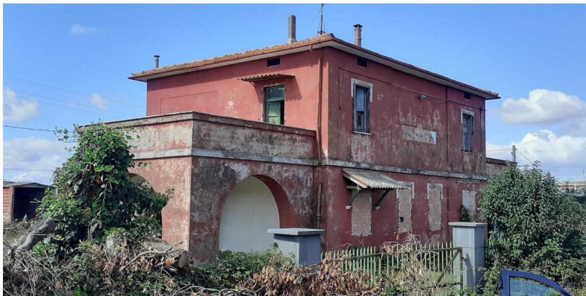
Una casa cantoniera abbandonata sulla strada statale 71, che va da Montefiascone a Ravenna (Gianluca Caramelli, Facebook )
